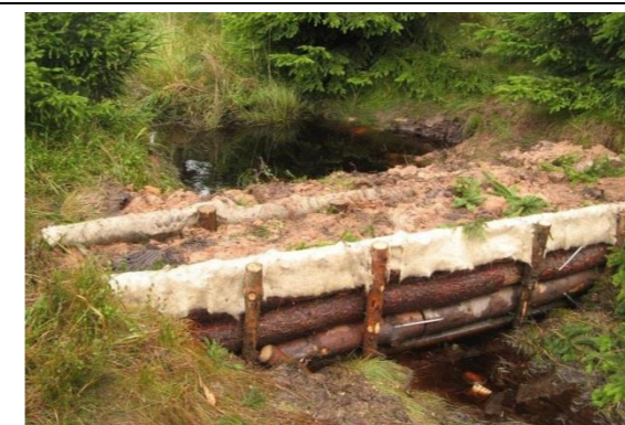
Obr. 25 Dvojitá těsněná srubová přehrážka
