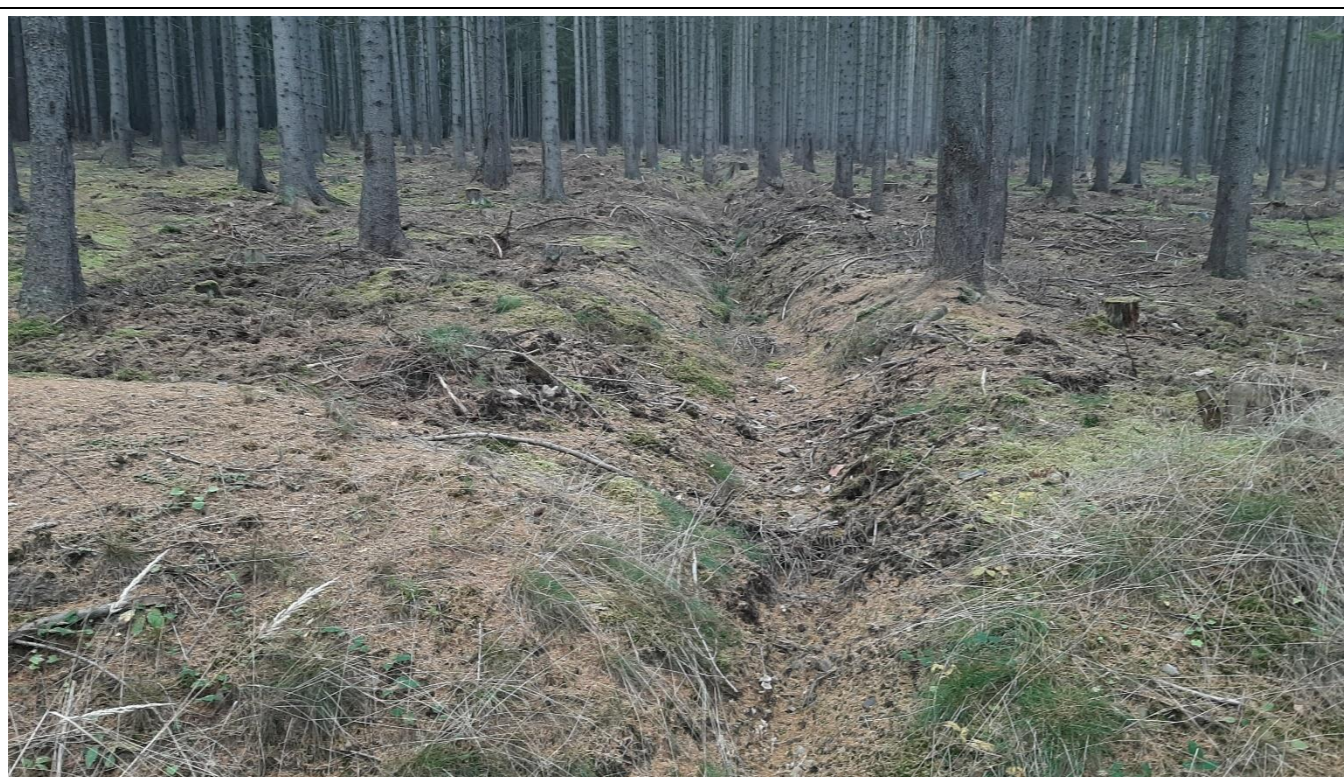
Foto 17 Odvodňovací příkop v lokalitě 20 U pěti zlodějů
