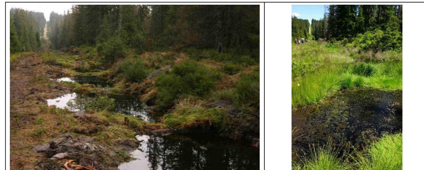
Obr. 34 Stav těsně po realizaci
