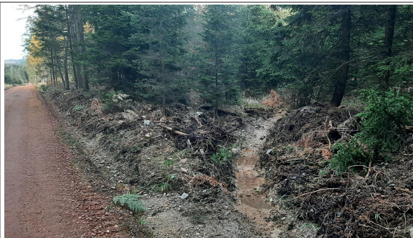
Foto 12 Ukázka realizovaného odlehčení cestního příkopu v lokalitě 1 Voložný potok
