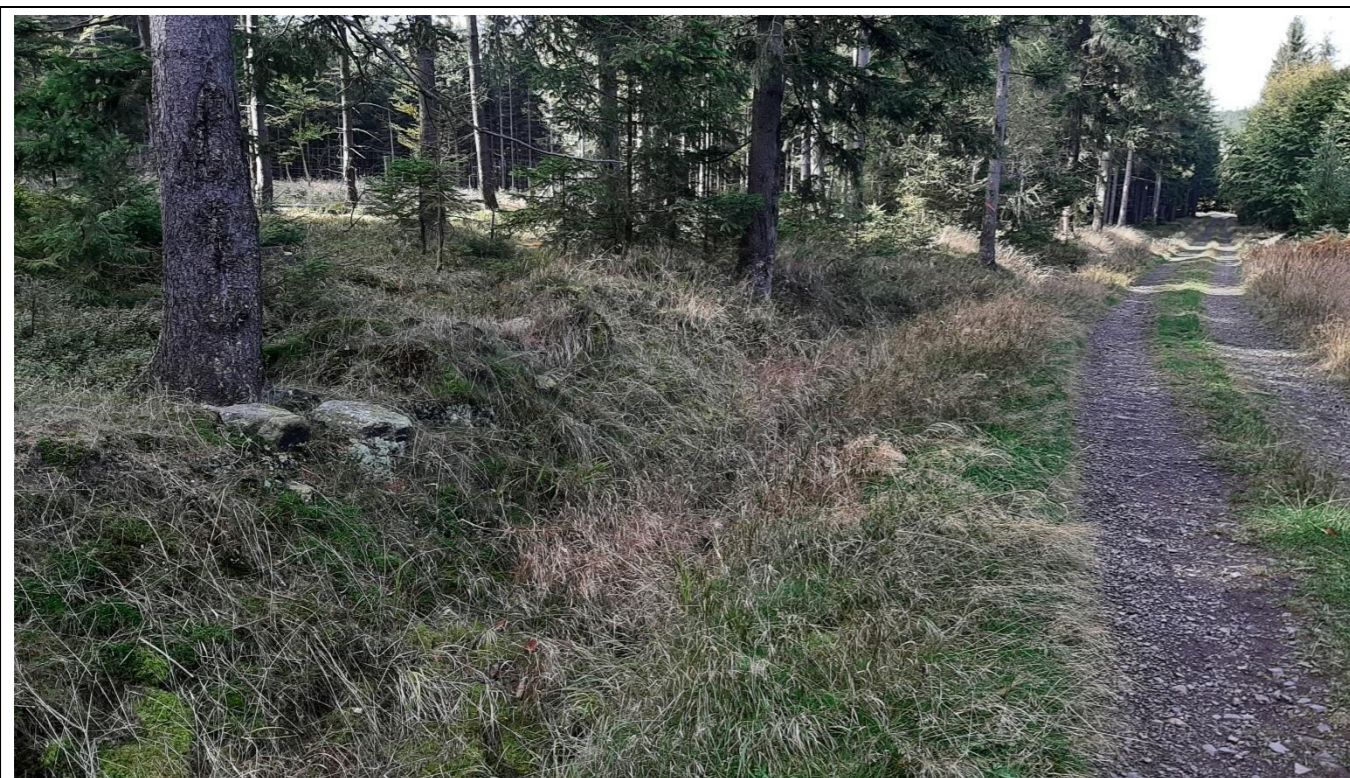
Foto 8 Příkop podél cesty bez propustků v lokalitě 6 Rozvodí Hlava - Jordán
