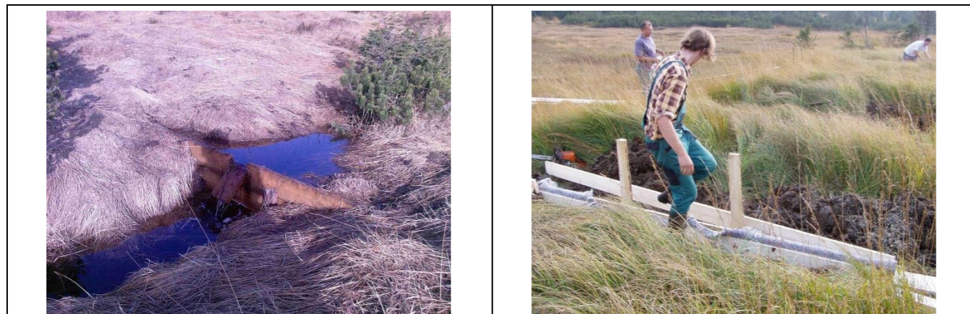
Obr. 33 Realizované přehrážky Klugeho louka
