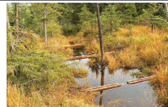
Fig. 31 Check dams constructed in NR Klečové louky
