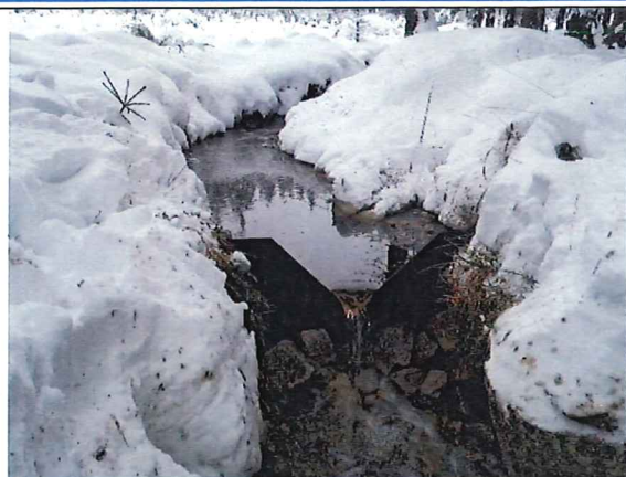
Obrázek 16: Instalace měrného přelivu 7.12.23
