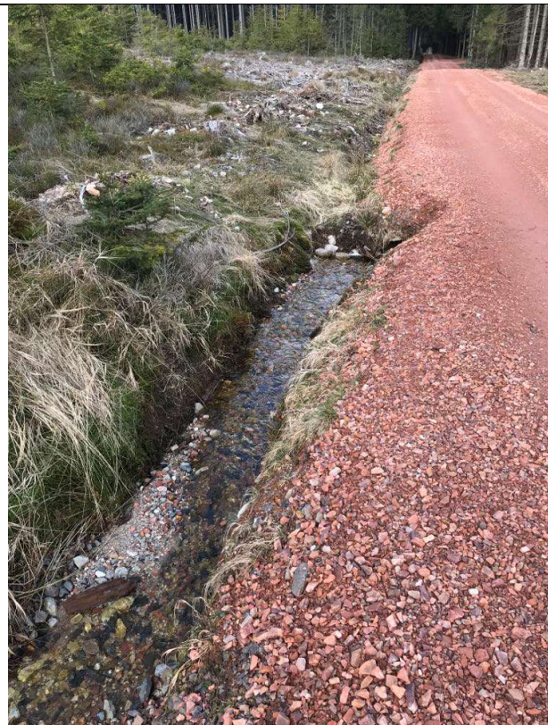
Obrázek 29: Stav nad propustkem pod cestou 13.3.24
