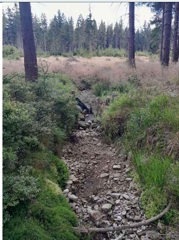
Obrázek 57: Koryto potoka pod měrným přelivem 21.7.2024
