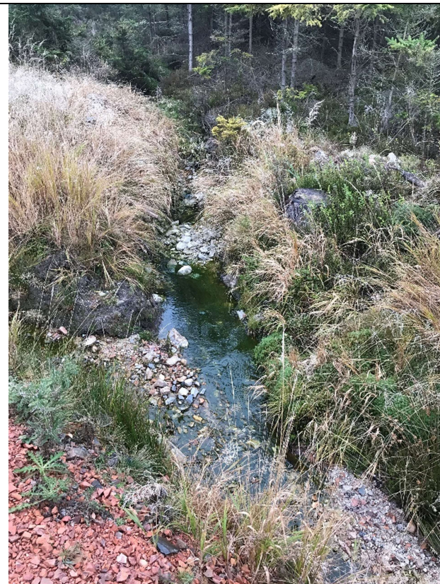
Obrázek 85: Nátok do propustku pod cestou 12.11.2024
