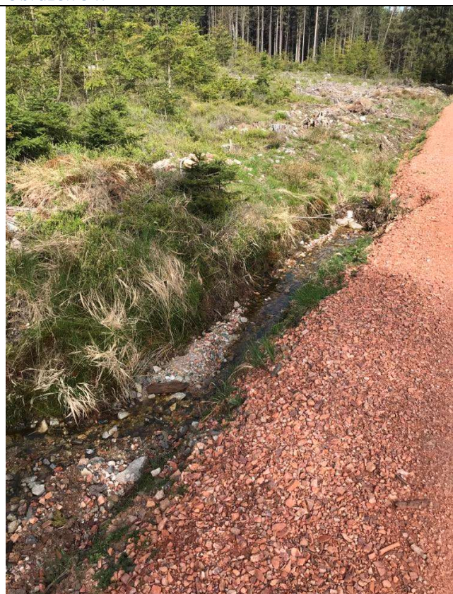
Obrázek 36: Stav nad propustkem pod cestou 9.4.24
