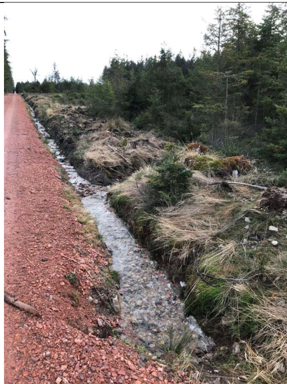
Obrázek 15: Stav nad propustkem pod cestou 28.12.23
