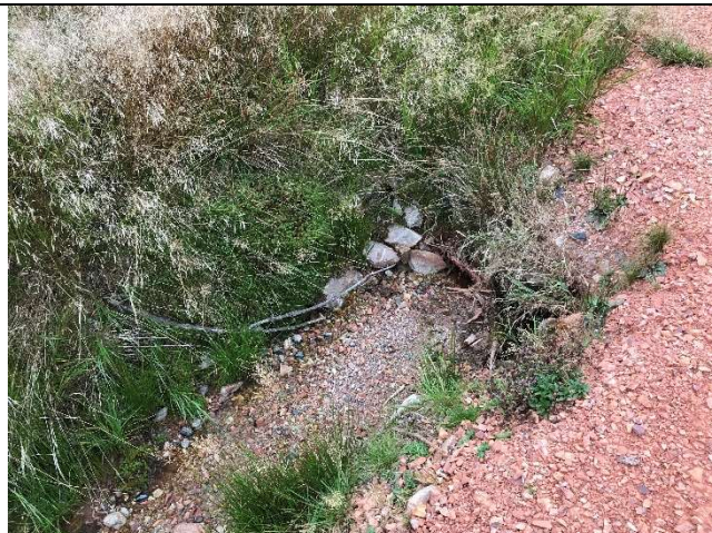
Obrázek 64: Stav nad propustkem pod cestou 25.8.2024
