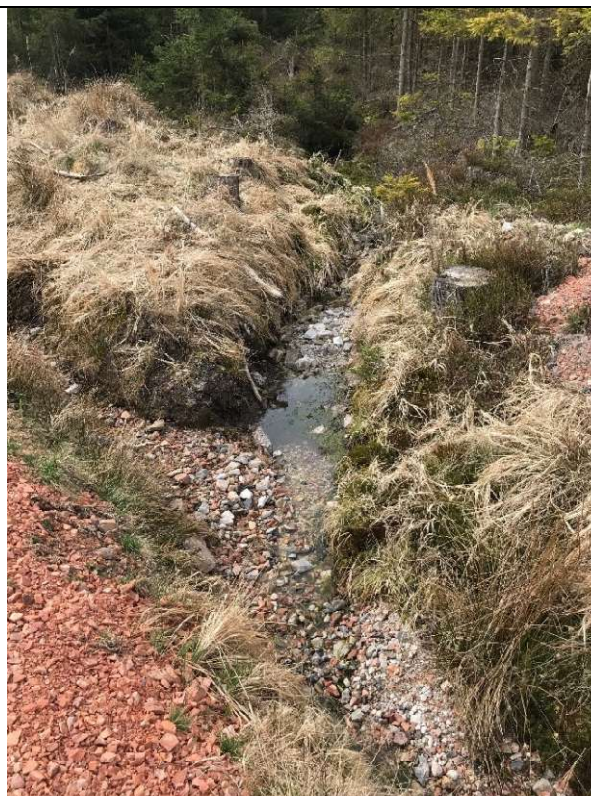
Obrázek 45: Stav nad propustkem pod cestou 13.4.25
