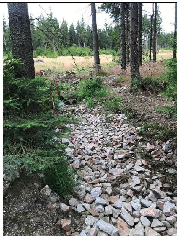
Obrázek 73: Koryto potoka pod měrným přelivem 24.7.2025
