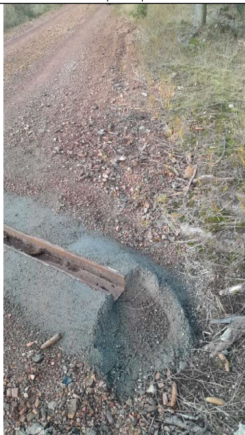
Obrázek 107: Nový žlab přes cestu na úrovni vrtu VP-2
