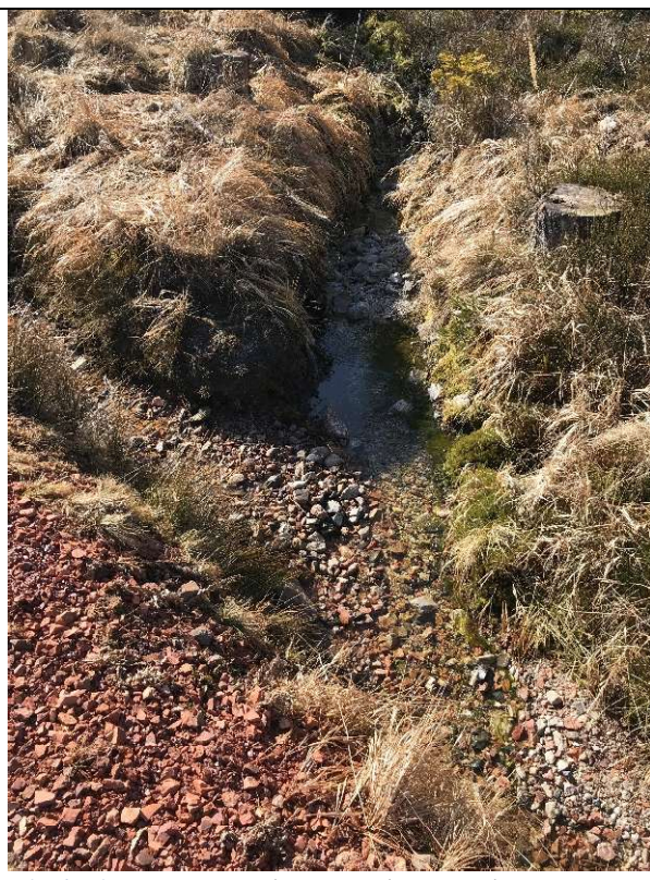
Obrázek 38: Stav nad propustkem pod cestou 8.3.25
