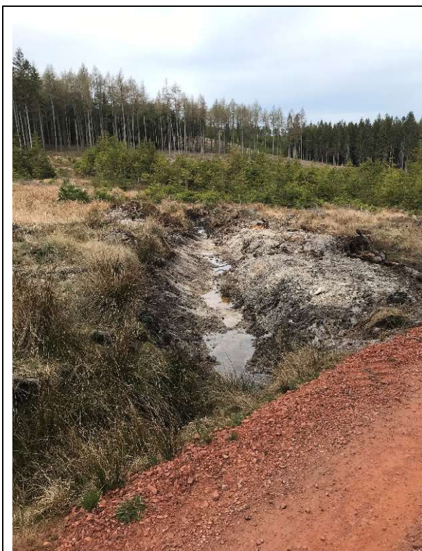
Obrázek 110: Nová rýha odvádějící vodu z příkopu u cesty
