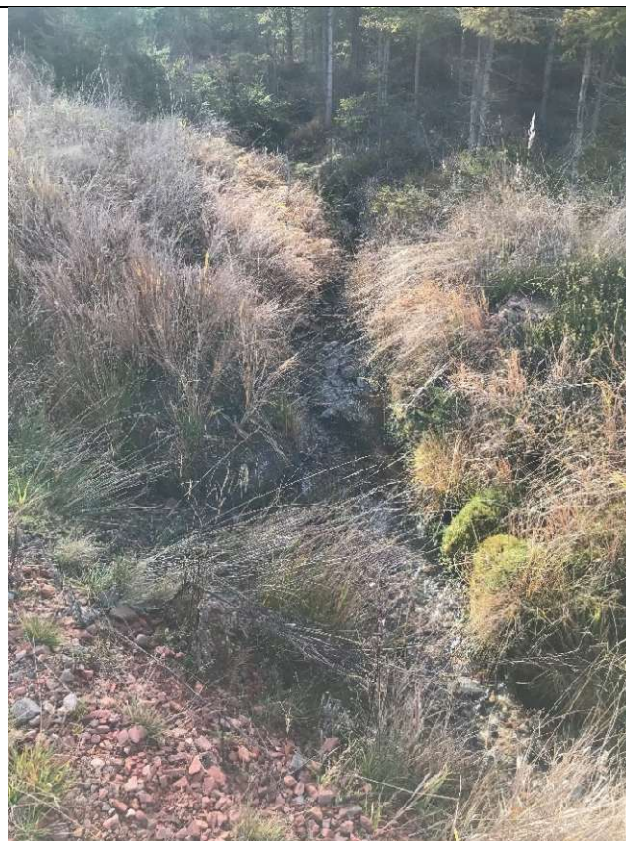
Obrázek 101: Nátok do propustku pod cestou 16.11.2025
