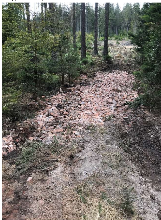
Obrázek 49: Pohled z Pražské linky vedle potoka – zpevněný terén kvůli technice.
