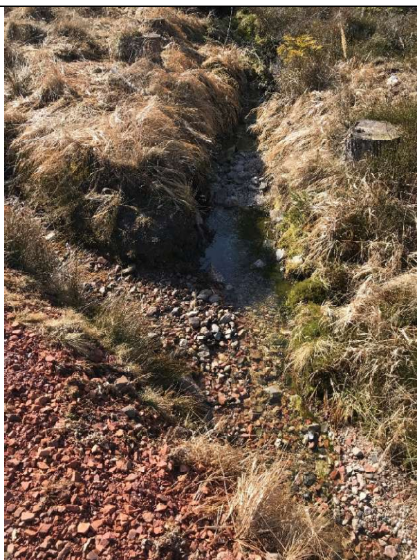
Obrázek 111: Koryto Vložného potoka v levé části povodí vtékající do příkopu podél cesty těsně před propustkem do pravé části povodí
