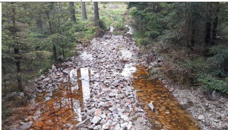
Obrázek 58: Pohled z Pražské linky vedle potoka – zpevněný terén 29.5.2025
