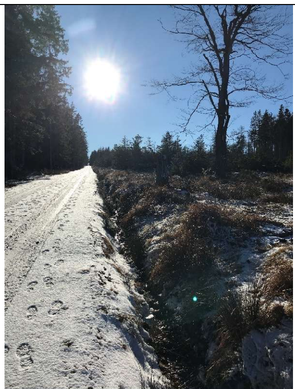
Obrázek 24: Stav na cestě na úrovni VP1 19.1.25
