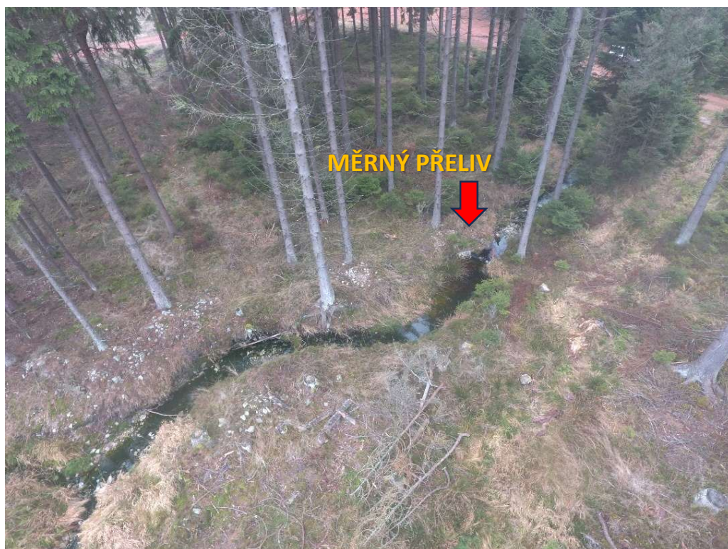
Obrázek 7: Pohled z výšky na umístění měrného přelivu na potoce – stav před úpravami koryta v 4/25
