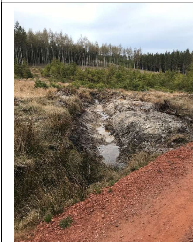
Obrázek 44: Nová rýha přes silnici od vrtu VP1
