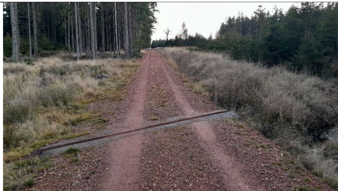
Obrázek 107: Nový žlab přes cestu na úrovni vrtu VP-2
